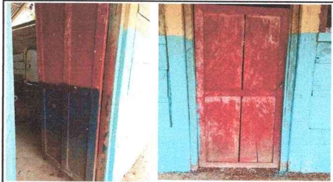
Foto 2: Cambio de puertas de aula
