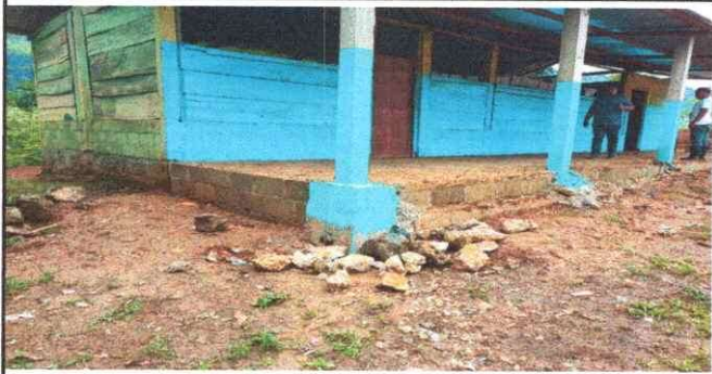
Foto1: Remozamiento de aula
